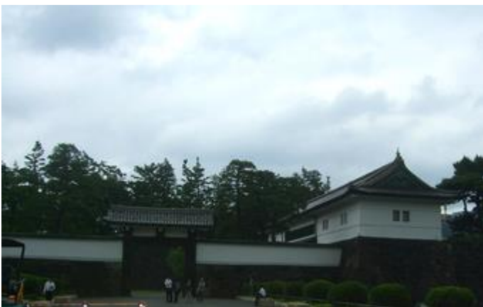
工事中の桜田門
